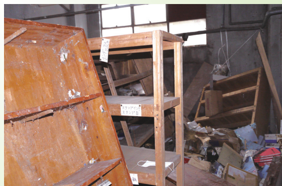
津波が押し寄せ水没した釜石市役所書庫
